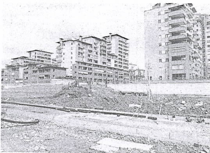
Lavori in corso davanti alle nuove case di Spina 3
