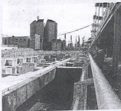
Lavori in corso alla Spina 3
