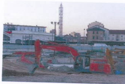
Il cantiere di piazza Baldissera
