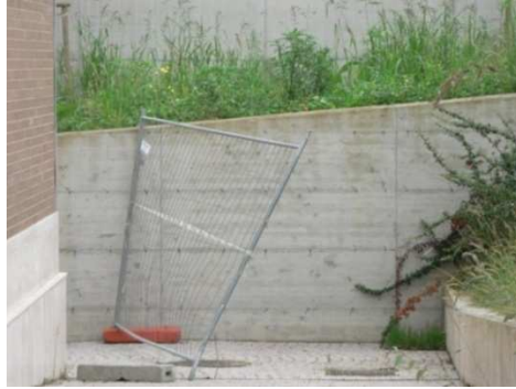
Giardino Lungo Dora: recinzione "virtuale", sarebbe invece utile una vera recinzione per l'accesso e una sua chiusura nelle ore notturne.
