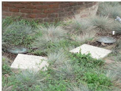
Giardino/parceggio di Via Pianezza: luci a ridosso della ciminiera, mai entrate in funzione
